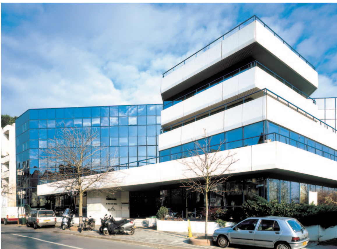
22 quai Galliéni • Suresnes (92)
