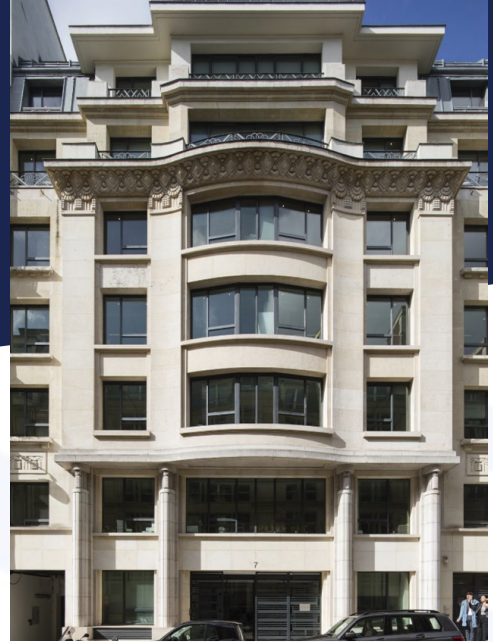
7 rue de Téhéran, Paris 8 ème (immeuble de bureaux)
